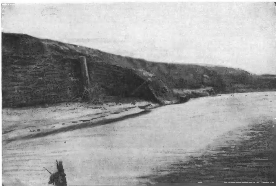
Фиг. 4. Сухое русло реки Песчанки после весеннего паводка на Илецком соляном куполе. Правый берег реки укреплен плетеным хворостом, местами подмыт и обвалился.
