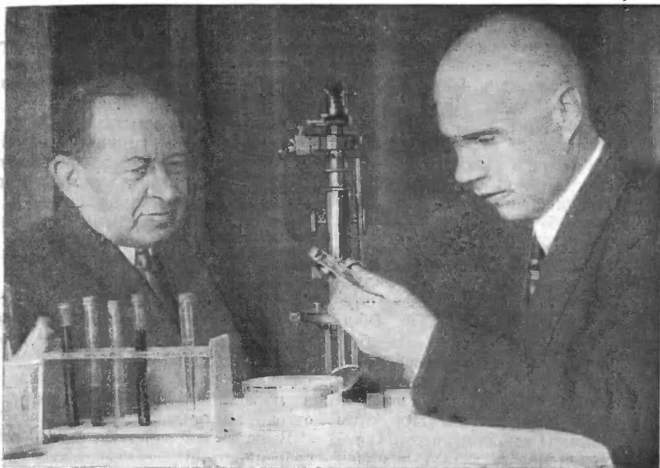
Фиг. 6. В. Н. Любименко у сконструированного им микроспектроколориметра для количественных определений растительных пигментов (Киев, 1932).
